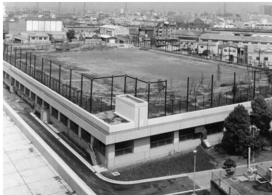
写真2.10.1.1 施設上部利用の事例（北部第一水再生センター）
